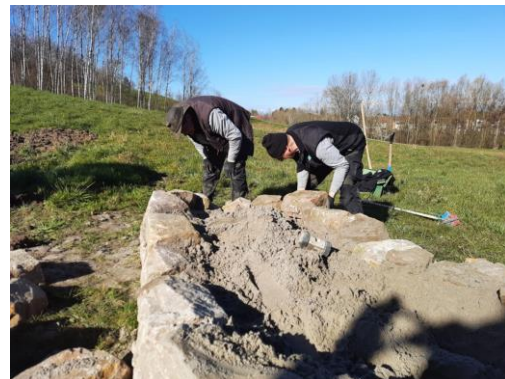
4. Mit Sandgemisch auffüllen, bis das Material mindestens eine Höhe von 60 cm hat
