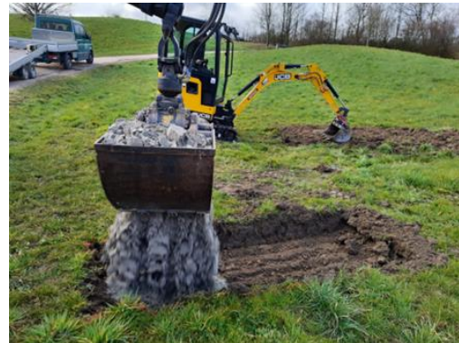
2. Graben mit dem Sandgemisch auffüllen
