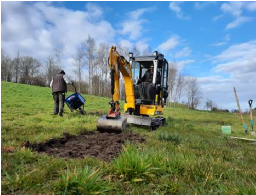
1. Boden abgraben (ca. 20 cm tief).
