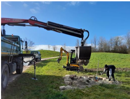
3. Material mit Trockenmauer oder Baumstämmen umfassen
